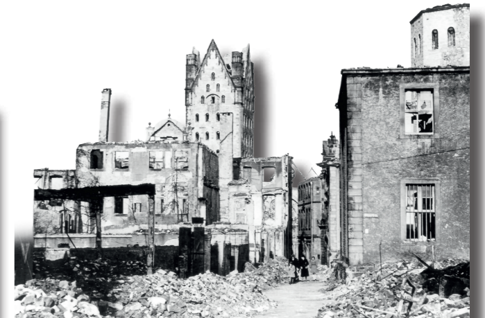
Blick auf den zerstörten Domturm von Paderborn, 1945/46
