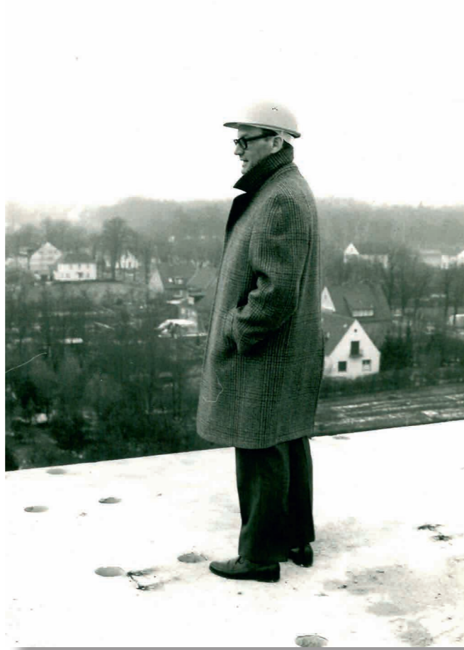
Heinz Nixdorf auf der Baustelle an der heutigen Fürstenallee, 1971
